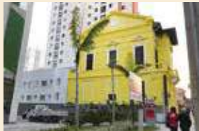
改修した山口県人会館と新宿舎 (左の建物)
